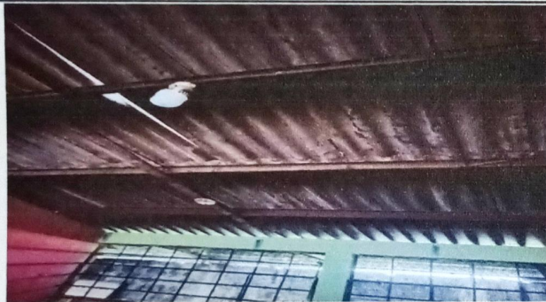
Foto 3: Mantenimiento a estructura de soporte de metal
