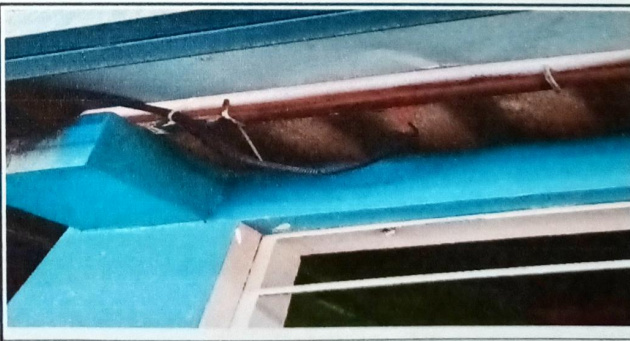
Foto 6: Reparación del sistema eléctrico
