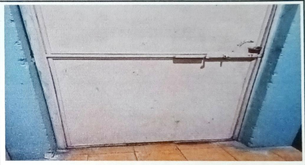
Foto 4: Sustitución de chapa
